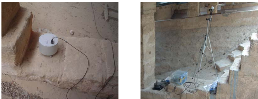
Figura 4. Acelerómetro triaxial (izquierda) y sistema con antena GPS (derecha) instalado sobre un arco toral de la Catedral de Mallorca.
