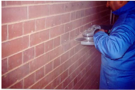
Ensayo para la estimación de características deformacionales.
