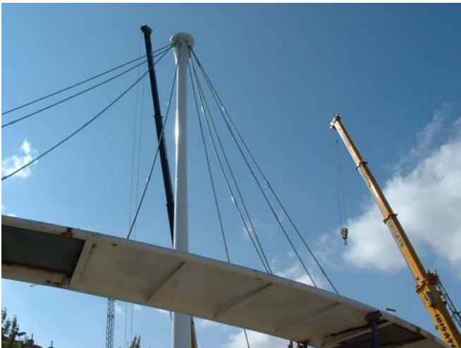
Vista general del mástil, elemento portante diseñado para absorber los diferentes esfuerzos transmitidos por los tirantes
