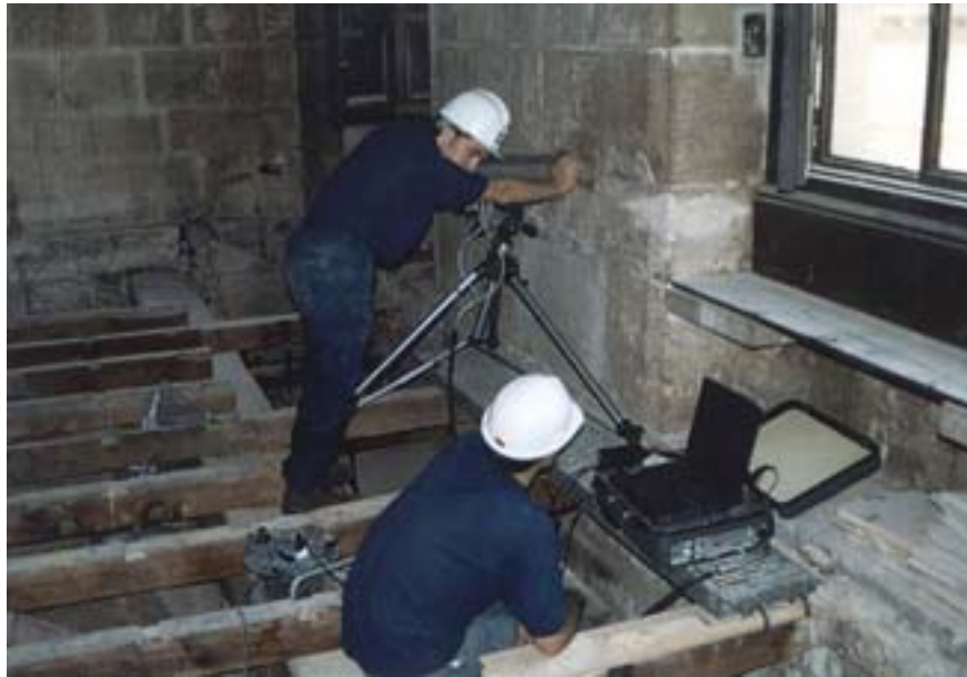
Figura 12.- Imagen del proceso del taladro.
