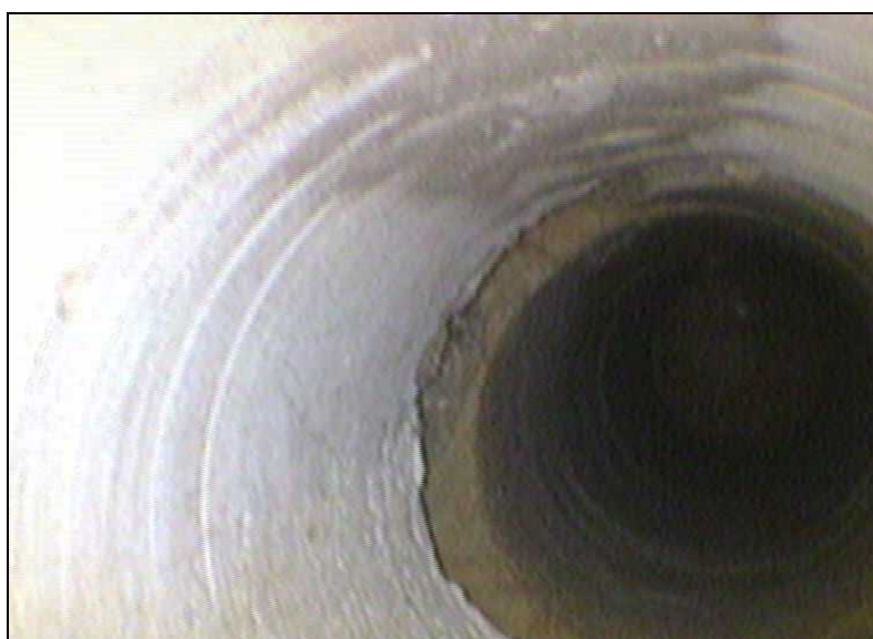
Endoscopia realizada en perforación del Testigo T1 donde se aprecia el relleno entre dos hojas del muro.
