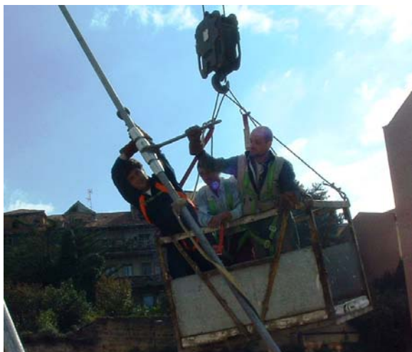
Detalle del proceso de posicionamiento geométrico mediante acortamientos o alargamientos de los enchufes con que se dotan los cables
