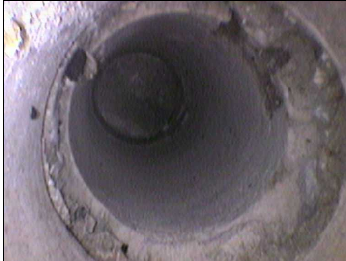
Endoscopia realizada en perforación del Testigo T3, donde se observa el relleno entre diferentes hojas del muro.
