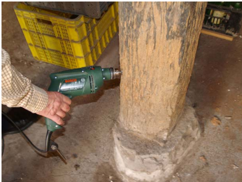
Figura 5.- Ejecución del “Simple Drill Testing”
