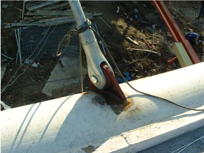
Detalle de la unión de uno de los tirantes con el tablero.
