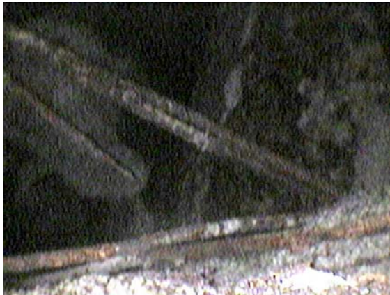
Armaduras que conectan ambas paredes
