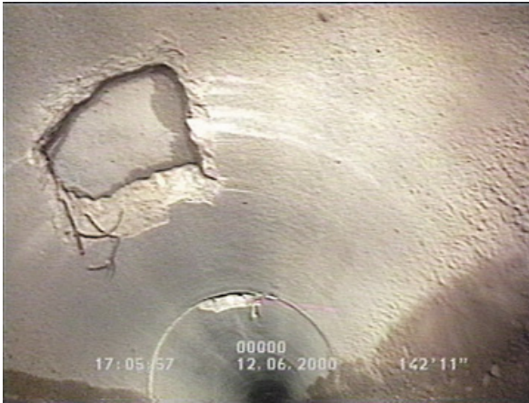
Daños en el interior de tuberías de hormigón.
