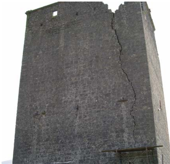
Figuras 2: Daños en los muros portantes de dos antiguos edificios y que en los estudios previos a su rehabilitación habrá que proceder a su análisis, diagnóstico y terapéutica.
