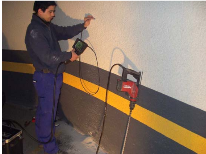
Proceso de realización de la endoscopia E-1 en la planta sótano -1.
