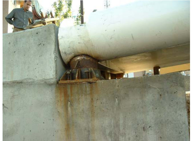
Apoyo de un extremo del tablero sobre el estribo
