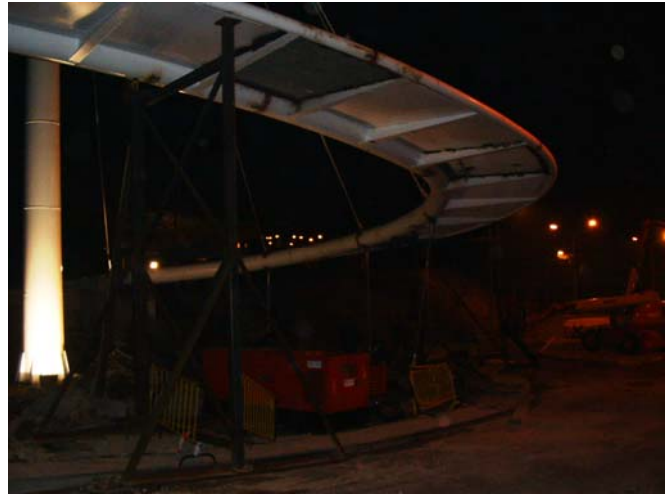
Fin del posicionamiento después de proceder a diversas fases de acortamiento o alargamiento de los cables
