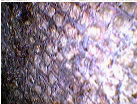
Tela metálica en pared exterior
