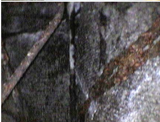
Armadura que une ambas paredes.
