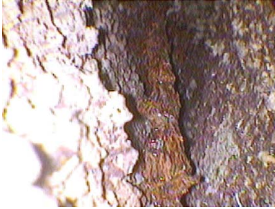
Hueco entre paredes con armadura horizontal
