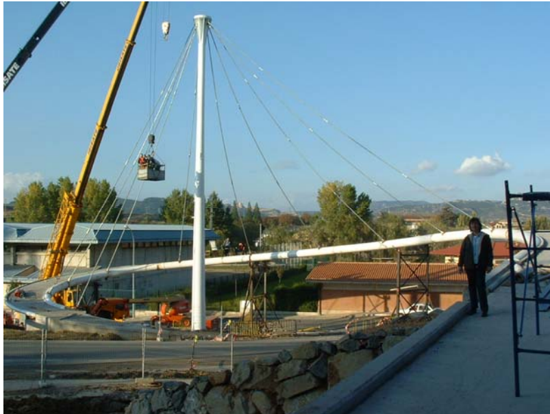
Pasarela en Haro (La Rioja), vista general
