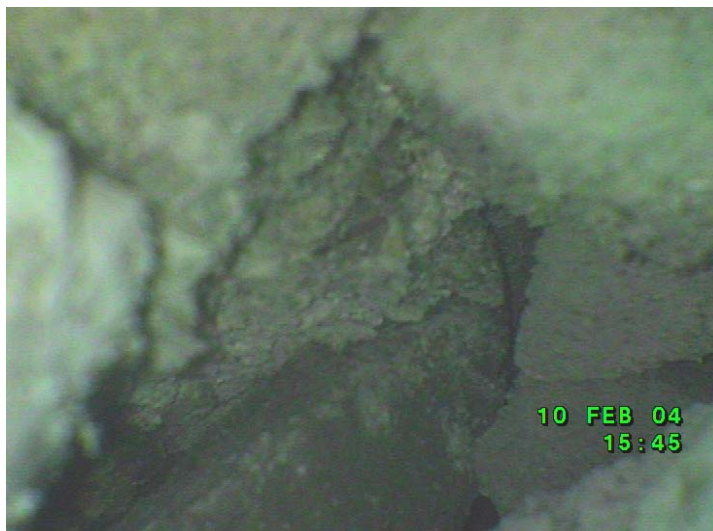
Vista del relleno heterogéneo (gravas y materiales varios) existente entre el muro de sótano y el "cajón" prefabricado del túnel.
