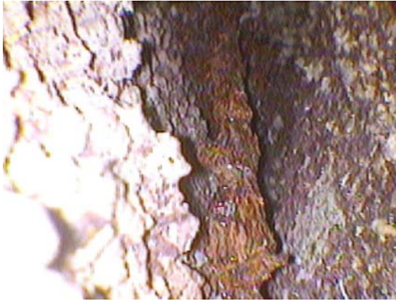
Hueco entre paredes con armadura horizontal
