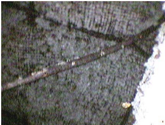
Parte inicial de armadura que une ambas paredes (desde pared exterior)
