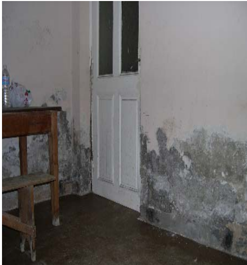
Fotografías 11: Defectos existentes en una obra objeto de rehabilitación, después de algunos años sin uso y sin mantenimiento alguno: A la izquierda pueden observarse importantes humedades de capilaridad, provenientes del terreno, en los muros. La imagen de la derecha muestra la pudrición por humedad y el colapso parcial de un forjado de viguetas de madera y bovedillas de ladrillo.
