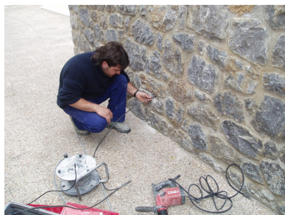
Situación de la inspección mediante endoscopio bajo el jardín del nº 30
