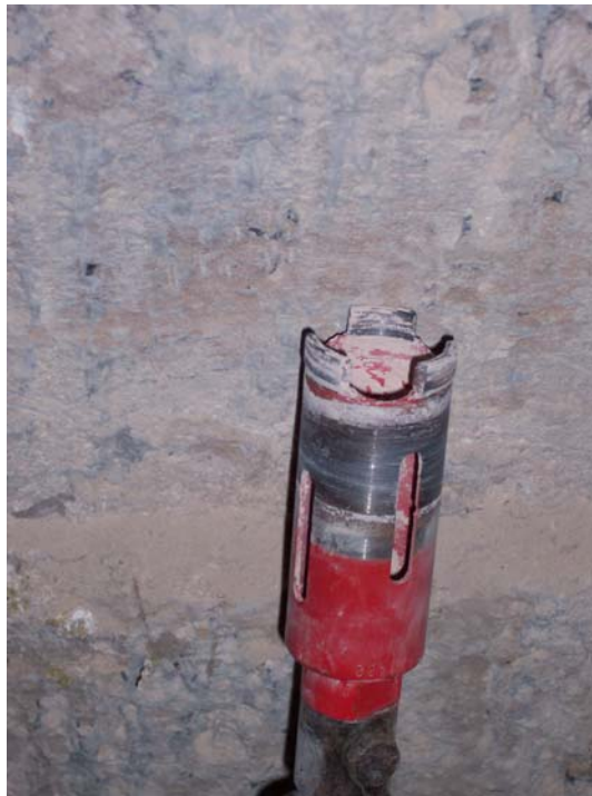
Figura 4. Corona de diamante utilizada para el taladro. Por claridad de la imagen se ha extraído la broca trazadora central.
