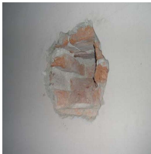
Figuras 8: A la izquierda se recoge un pozo realizado junto a un muro de carga (para conocer el tipo de terreno de cimentación y la profundidad del NF). A la derecha se muestra un aspecto de la constitución del citado muro (una fábrica de ladrillo macizo).
