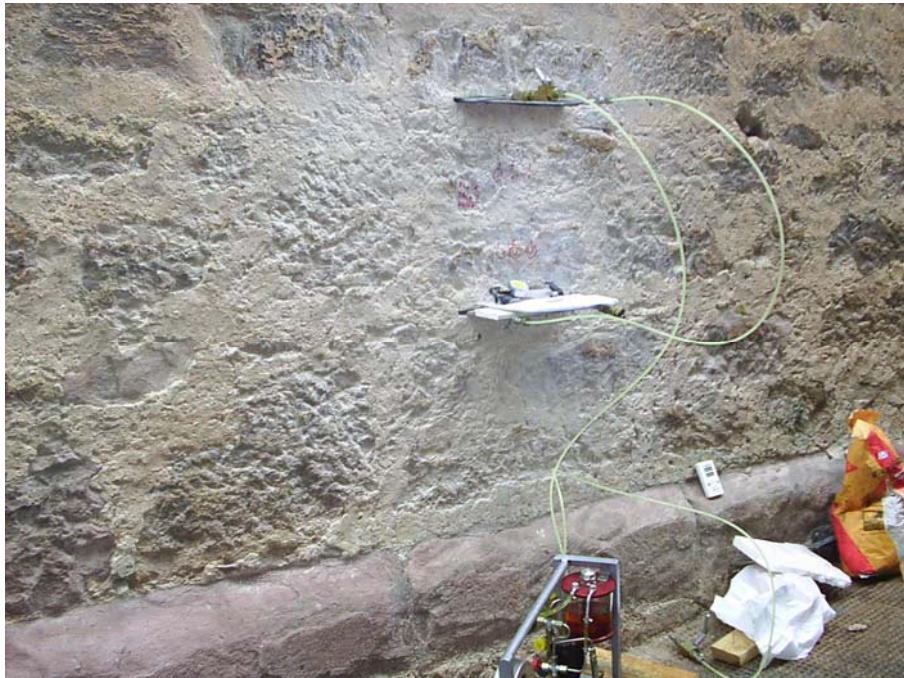
Figura 18.- Colocación de doble gato en fábrica de mampostería
